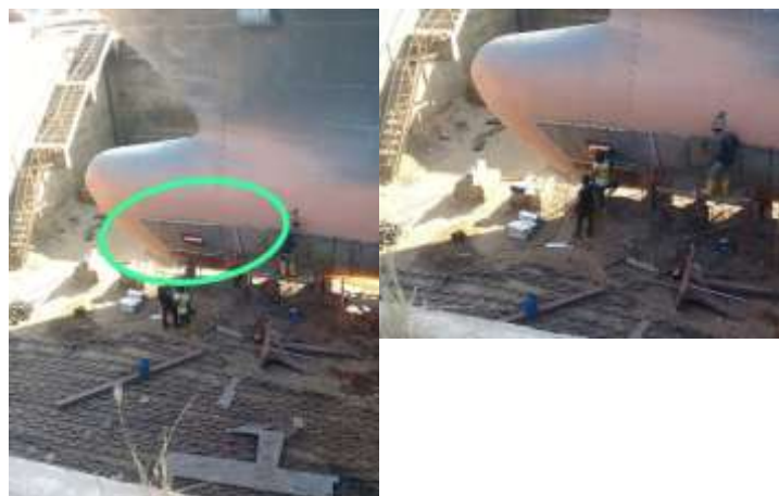
Gambar 1. Cara Pemasangan Zinc Anoda
