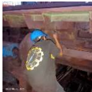
Gambar 5. Pengecekan Roll Table dan Rubber Coupling Entry
